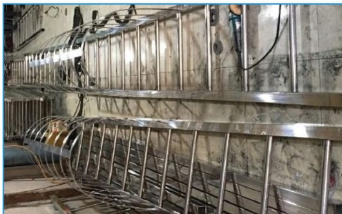
GIA CÔNG BỆ QUẢN TÍNH CHO BƠM VÀ CHILLER MACHINING OF INERTIA BASES FOR PUMPS AND CHILLERS
