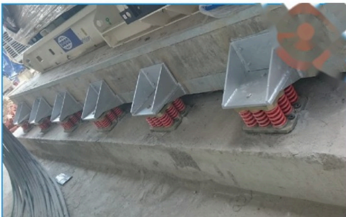
GIA CÔNG BỆ QUẢN TÍNH CHO BƠM VÀ CHILLER MACHINING OF INERTIA BASES FOR PUMPS AND CHILLERS
